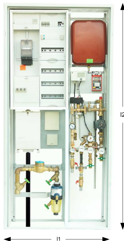
Abbildung 5: Darstellung einer Hausanschlussnische
